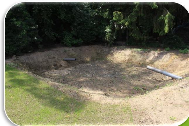
3. Buffering op eigen terrein met vertraagde lozing
