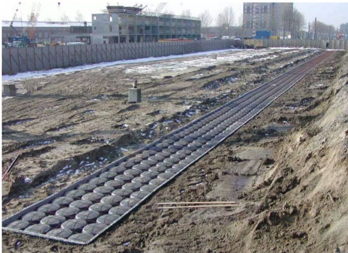
Aanleg van ondergrondse buffervoorziening – Waterblock BV
