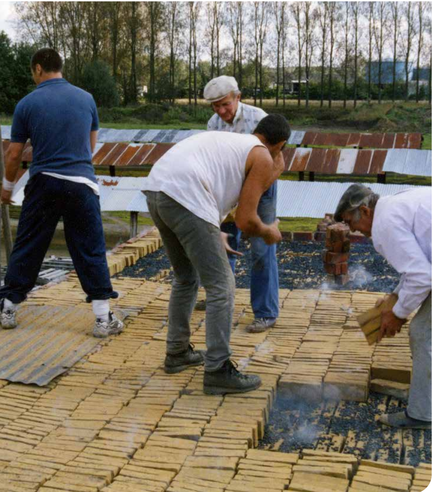
Vroeger werd een oven laag per laag opgebouwd. Steenbakkerij Danneels in Eke was de laatste die nog op deze traditionele manier werkte.
